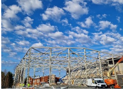
Kuva C-lohkon liikuntahallin teräsrunkoasennus käynnissä
